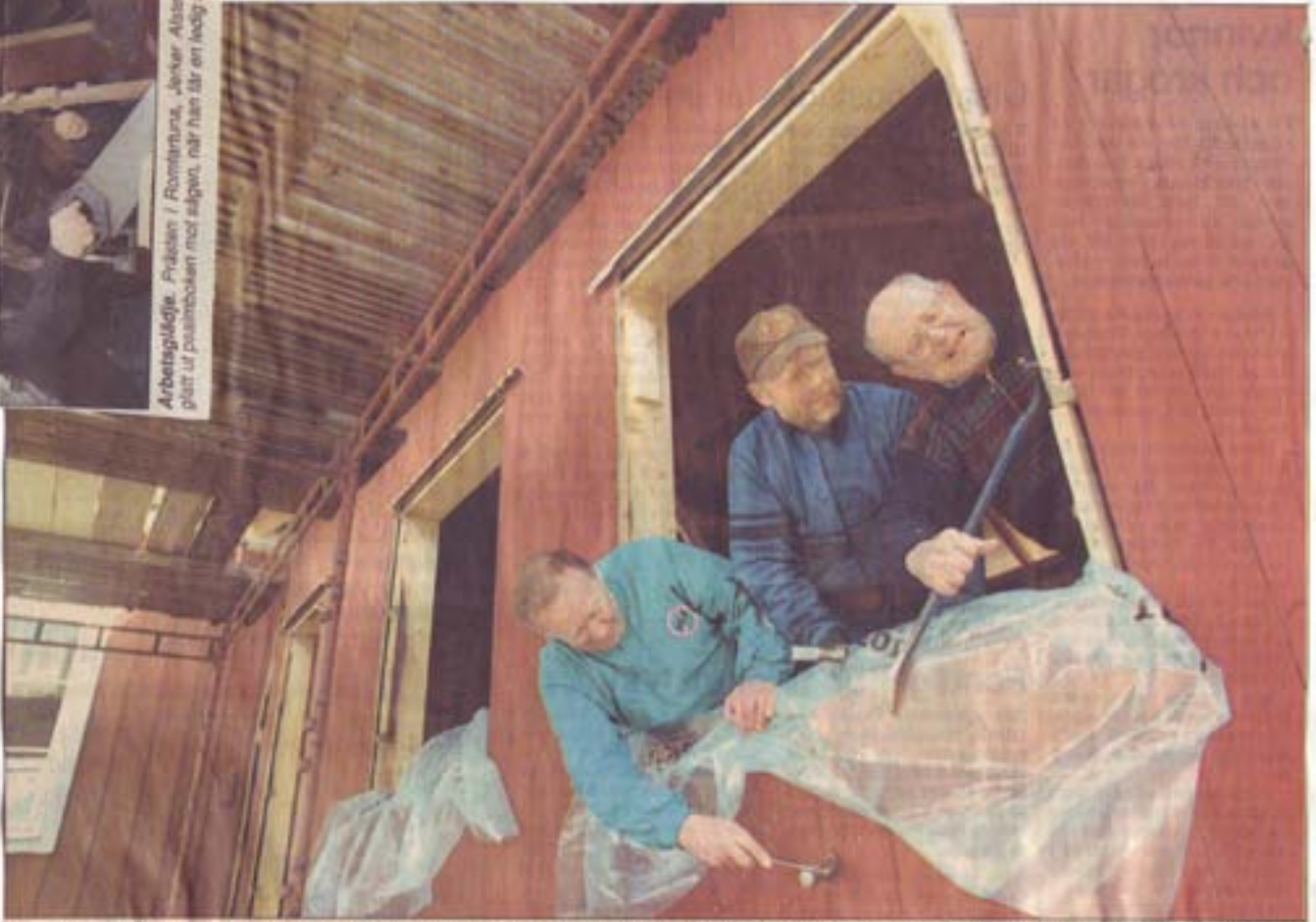
Ekonomiskt bygge. Sven Blomdahl, Pelle Råms och Gunnar Johansson hjälps åt att ta bort fönstren i den gamla kyrkvaktmästarbostaden. Fönstren ska flyttas över till den nybyggda delen för att återanvändas.
